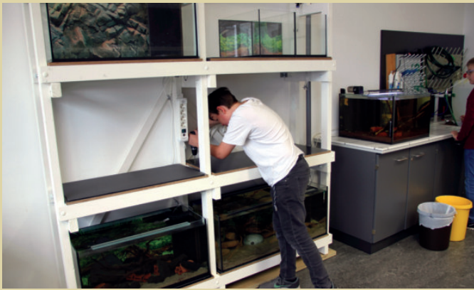
Montagearbeiten am Regal.
